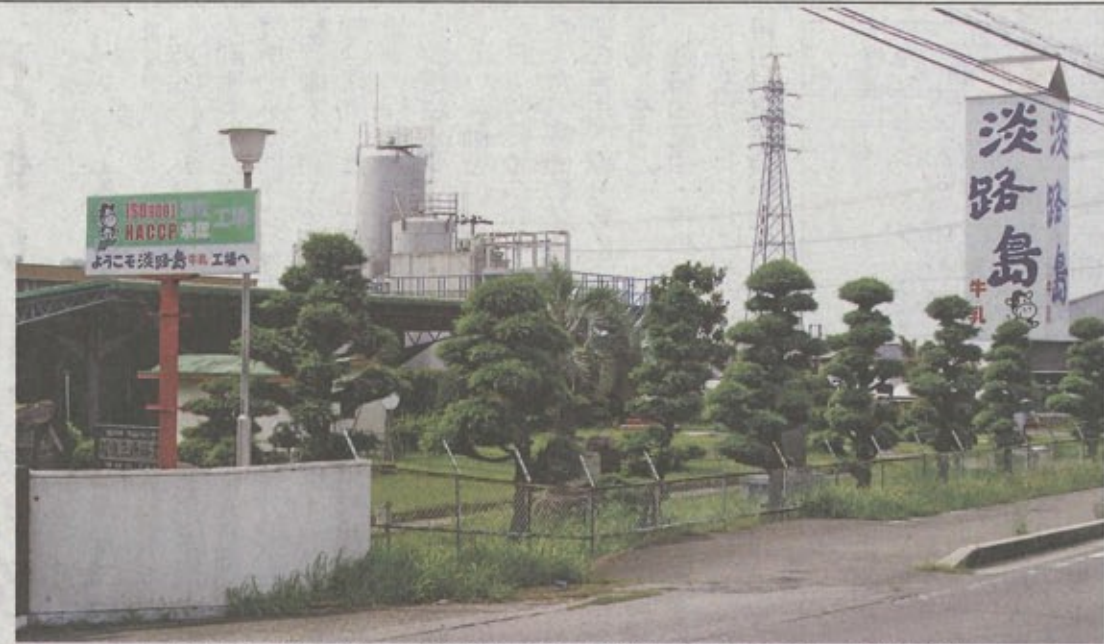
工場廃止も検討されている淡路島酪農農業協同組合の工場—南あわじ市
